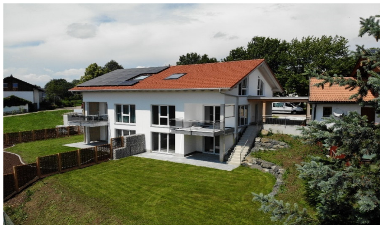
Aufnahme des bereits fertiggestellten Doppelhauses Drechselweg 11a & b
